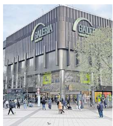
Ein neues Logo für die Fassade wird nötig: Das Gebäude von Galeria Karstadt-Kaufhof in Hannover am Ernst-August-Platz. FOTO: CONRAD VON MEDING
